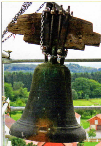
Die Glocke vor der Abnahme am entkernten Kirchturm.
